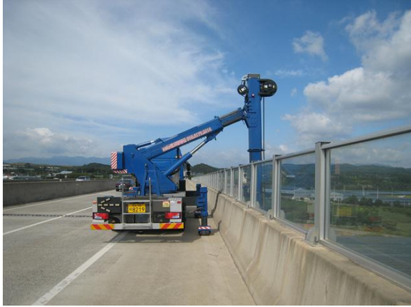
교량점검차를 이용한 근접조사
