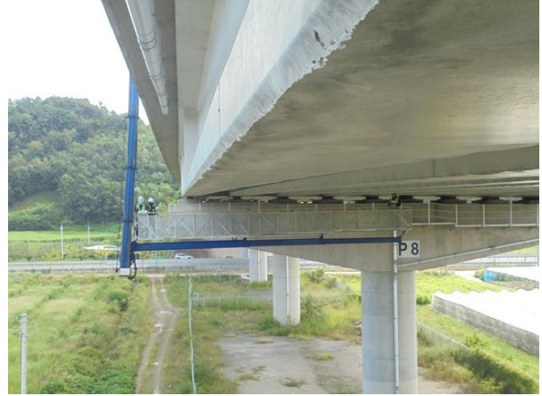
교량점검차를 이용한 근접조사
